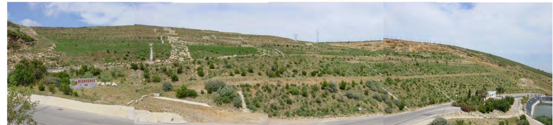
VUE 2 depuis l'intérieur du site, en juin 2010
